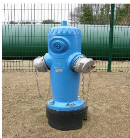
Poteau d'aspiration de 150 mm, muni de deux sorties de 100 mm et d'un carré de manœuvre.
