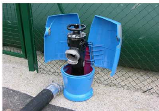
Poteau d'aspiration de 100 mm, muni d'une seule sortie de 100 mm et d'un volant de manœuvre
