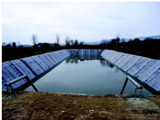
Réserve incendie 1500 m 3
