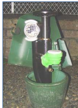
Intérieur d'une borne de puisage avec 1/2 raccord de 65 mm et compteur d'eau
